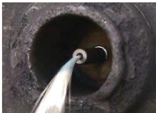
5. ábra. A bemeneti kapuba befűzött, áthúzásra előkészített CeraFib 99 szálköteg
